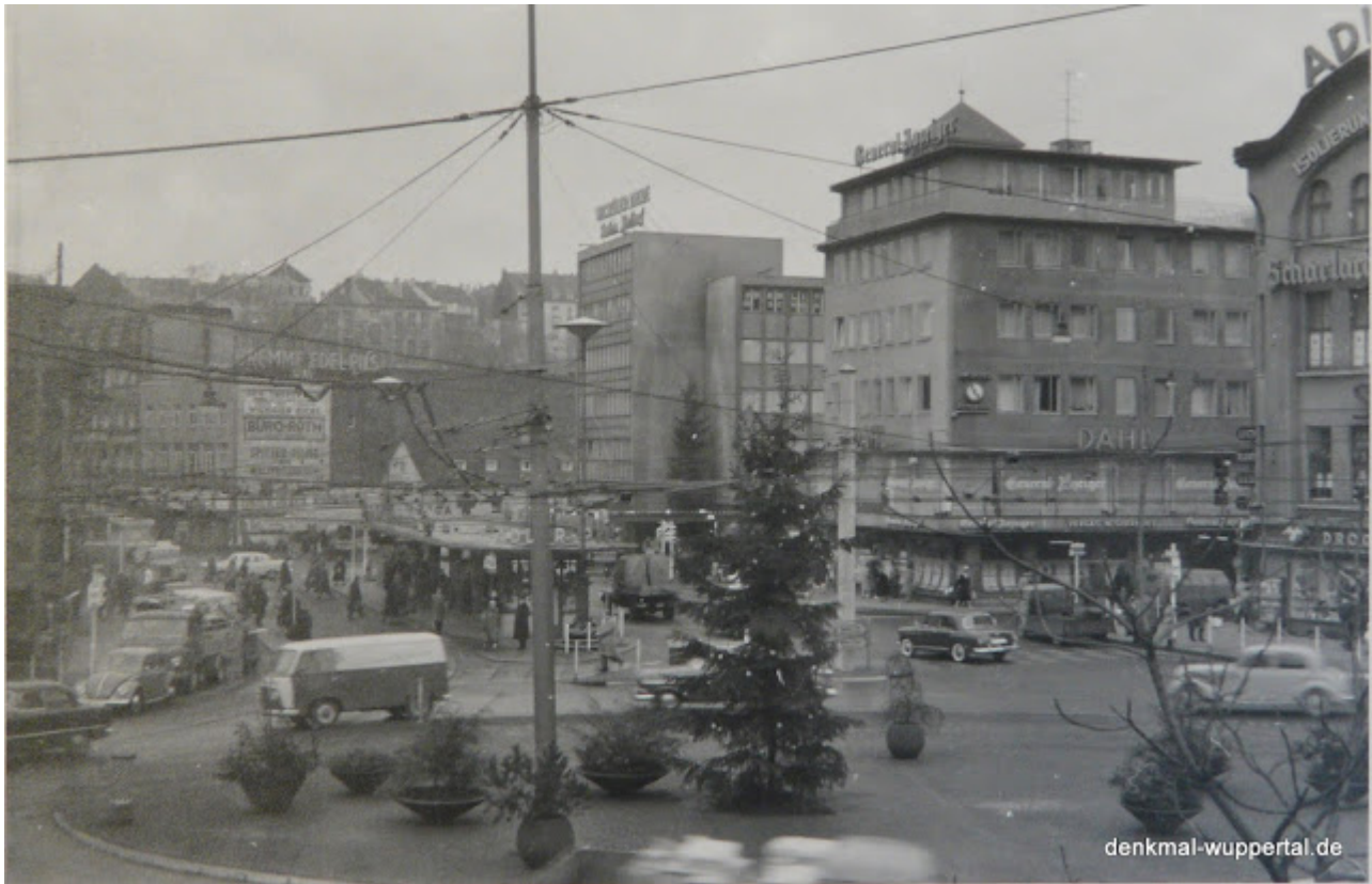
Blick von der Schwebebahnstation auf den Verkehrsknoten Alter Markt, 1959. Stadtarchiv Wuppertal, 12.6.1
